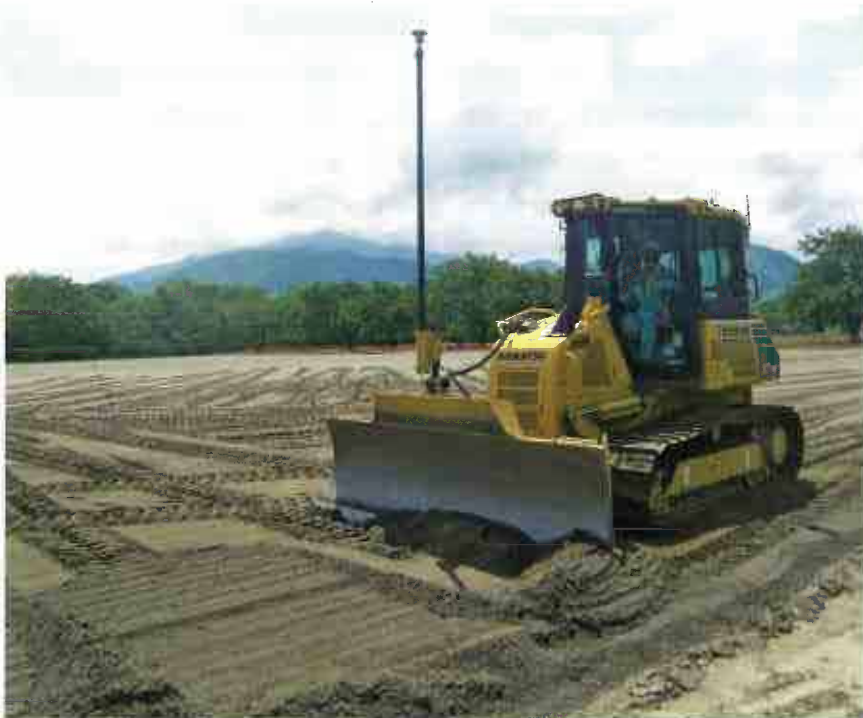
自動制御ブルドーザーでの整地
