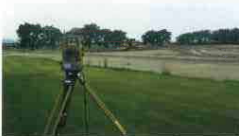
三次元（3D）トランシット設置
